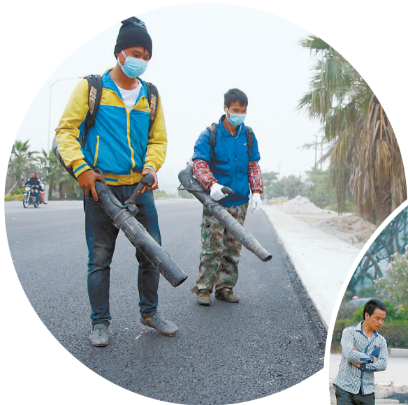
1月19日,珠峰大道正在进行全面收尾工作,工作人员用风机对路面进行清理。 本报记者 曾遥 摄
