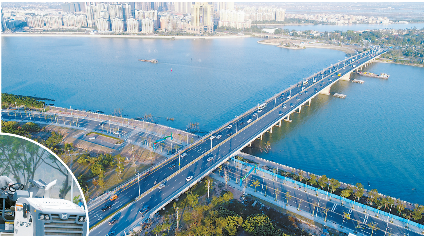
横跨一河两岸的斗门尖峰桥路面焕然一新。 本报记者 曾遥 摄
