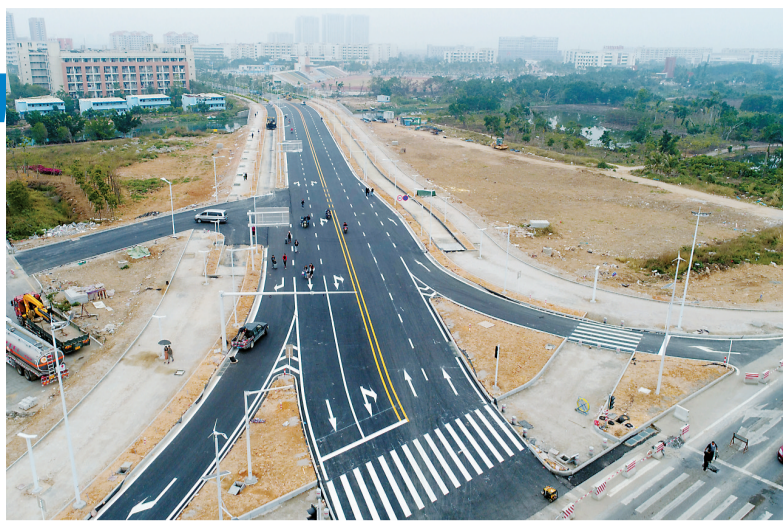
1月19日,建设中的金湾金鑫路。 本报记者 张洲 摄
