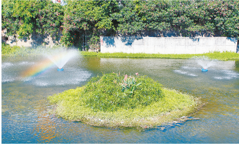
造贝排洪渠河道治理提升项目运用了微孔曝气技术和生态浮岛净化技术。
