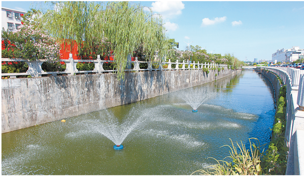
105国道排洪渠河道治理提升项目运用了微孔曝气技术。
