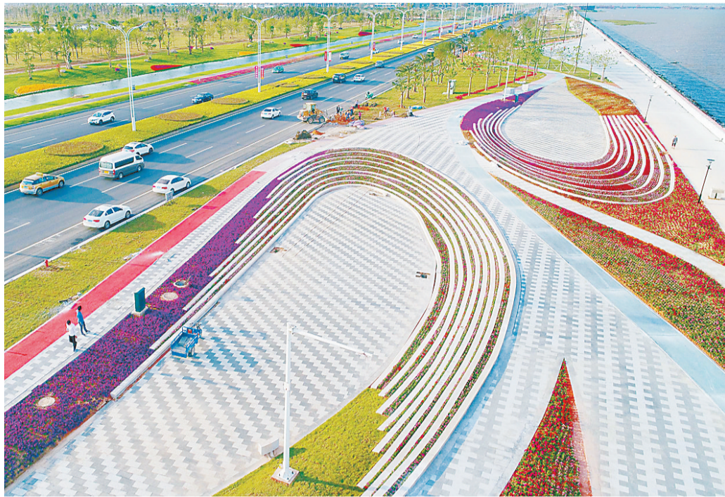
机场东路绿化美化提升工程一期项目整体形象进度基本完成。
