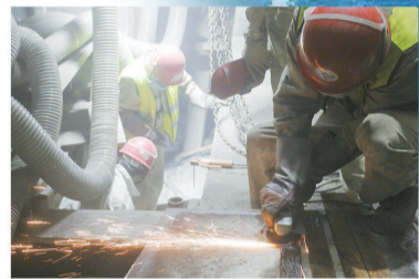
5月10日,港珠澳大桥海底隧道最终接头与E30管节连接处工人在进行焊接作业。 □本报记者 钟凡 摄
