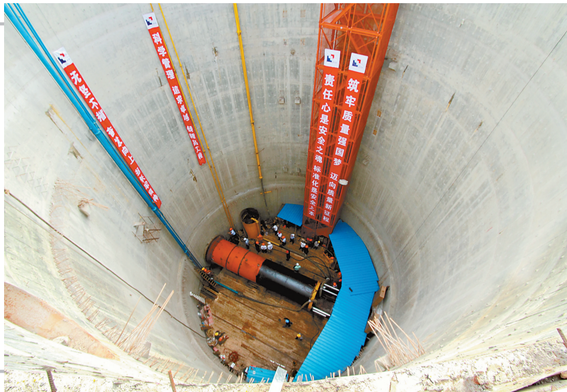
顶管施工现场。 珠海水控集团供图
