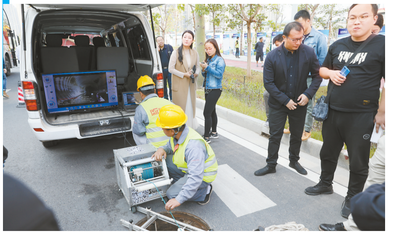
相关单位在检测城市排水管网系统。
