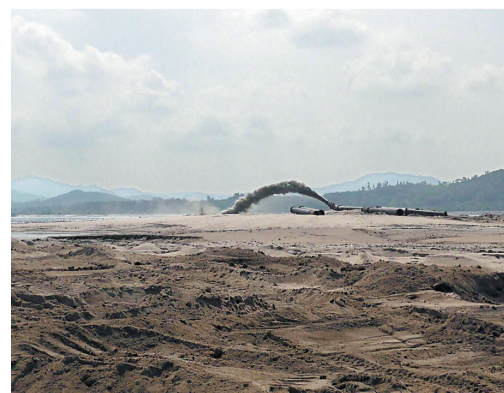
二围吹填现场。
