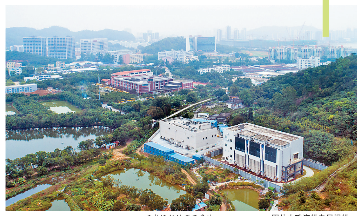
正式运行的项目基地。 图片由珠海供电局提供
