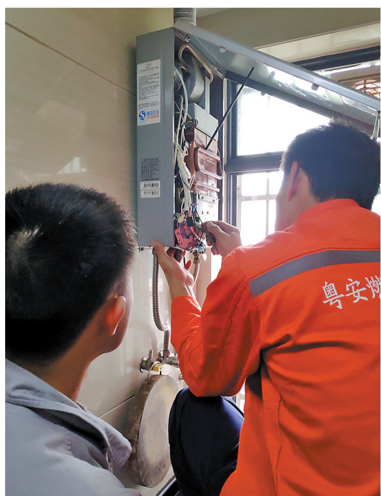
施工人员进行入户安装检查。 本报记者 曾遥 摄
