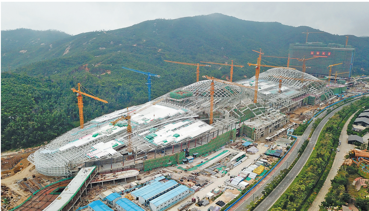
建设中的珠海长隆海洋科学乐园。 通讯员 梁旭 摄
