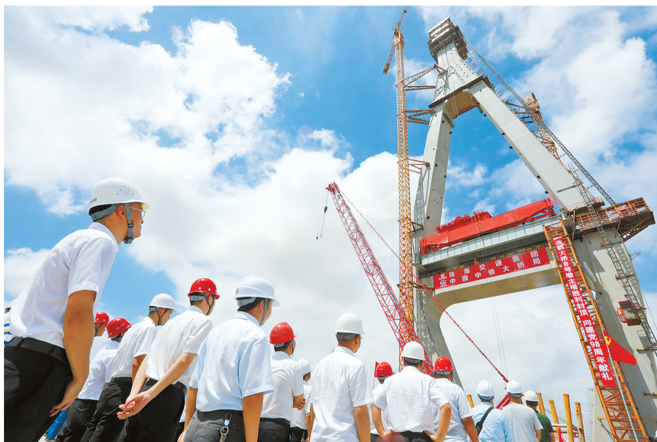
7月1日上午,洪鹤大桥首个主塔封顶。本报记者程霖摄
