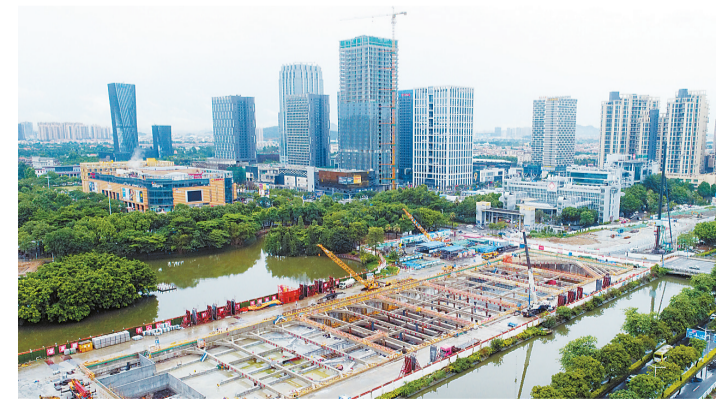
建设中的广州地铁7号线一期工程西延顺德段佛山北滘新城站。
