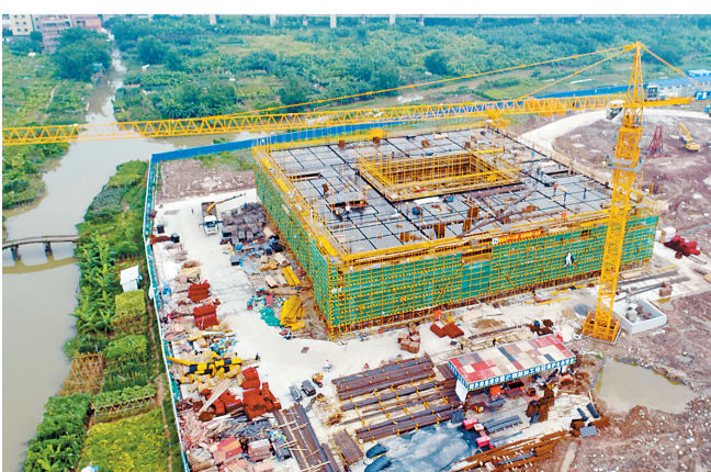
建设中的季华试验室。
