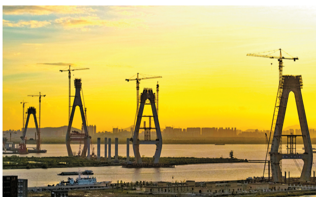
建设中的洪鹤大桥。
