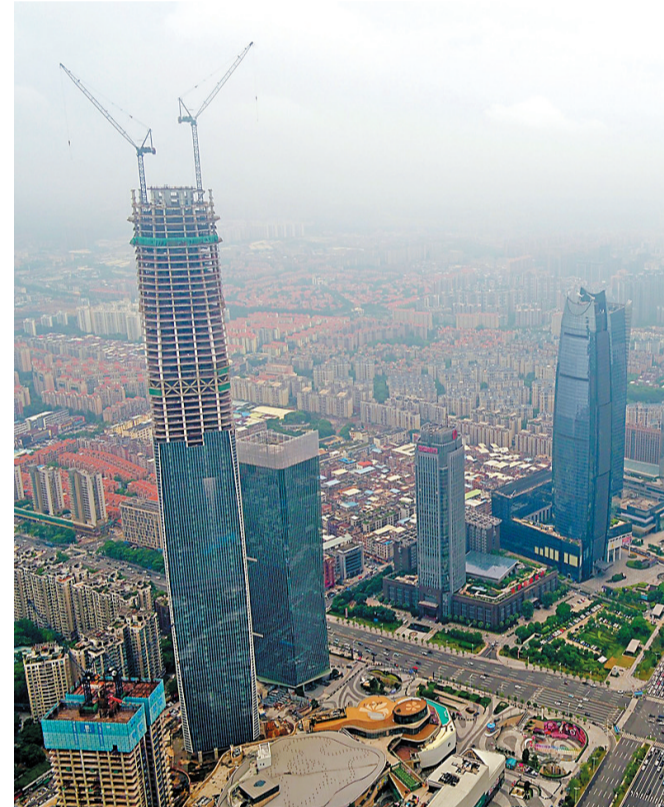
东莞新地标国贸中心正在建设当中。 本报记者 曾遥 摄
