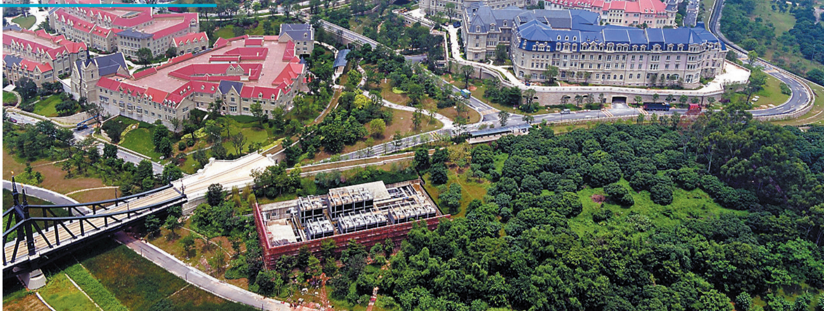
东莞松山湖的建设高起点布局,大手笔投入。
