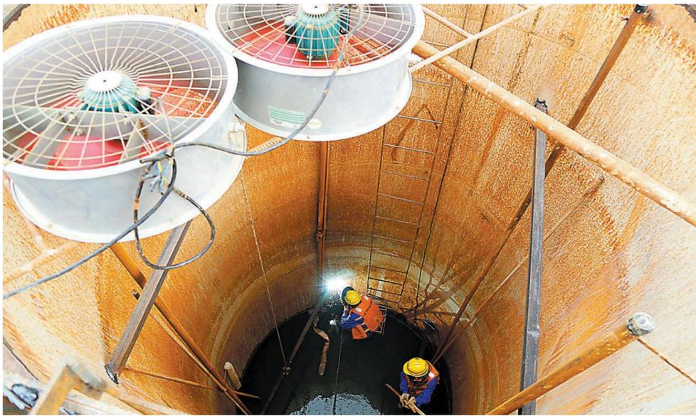
工人在钢护筒内进行焊接施工。 通讯员 孟庆虎 摄
