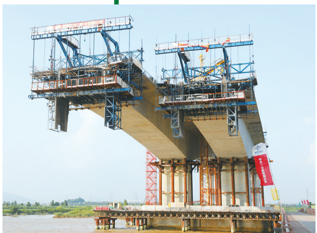
正在紧锣密鼓施工建设中的香海大桥。
