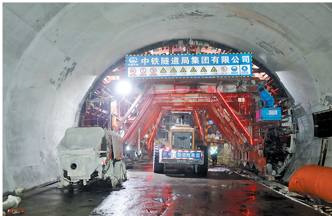
7月27日,板樟山新增隧道,工人在隧道贯通段作业。
