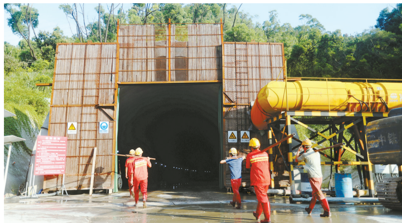
工人扛着材料进入施工隧道。
