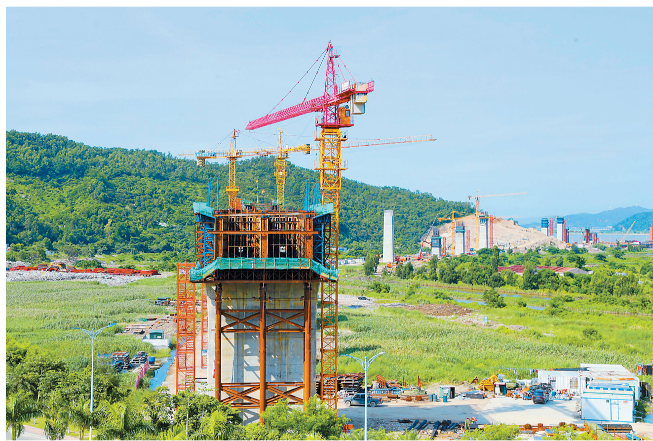
8月7日，珠机城际二期工程首个连续梁拱3号墩0#块浇筑现场。
