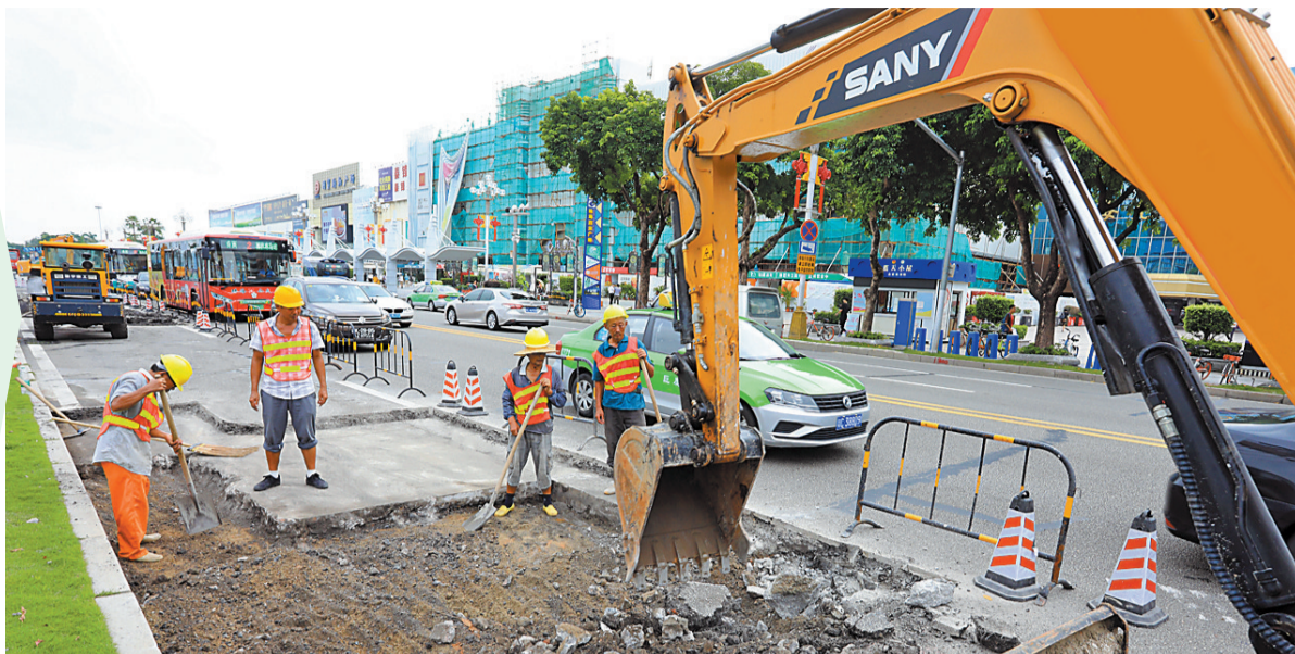
景山路病害处理已开始“封一通二”施工。
