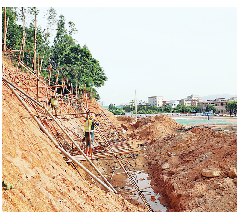
施工人员正在对地质灾害点进行整治。
