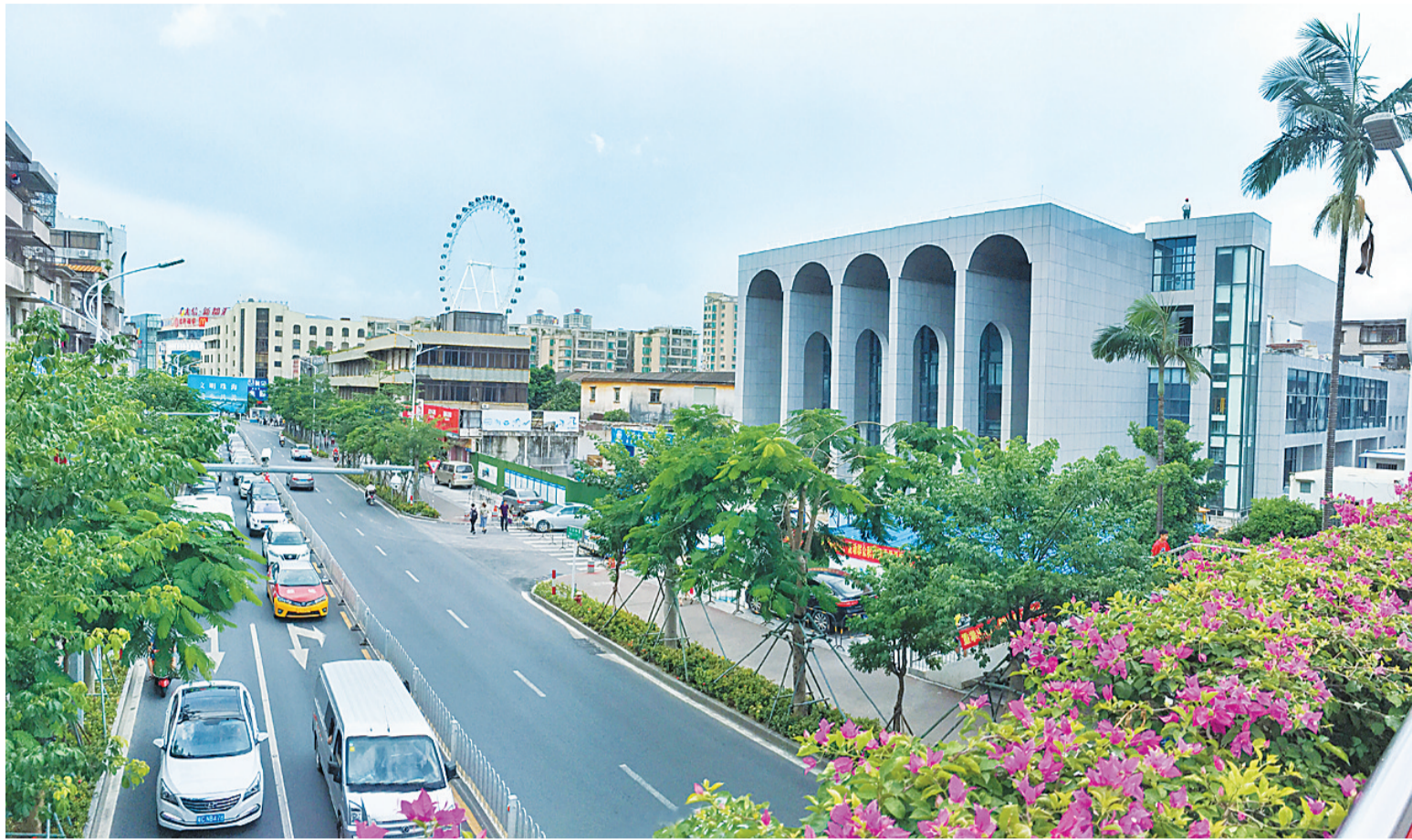
井岸影剧院经过斗门国企文旅公司升级改造后,将变身成为“斗门礼堂”。
