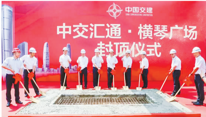
中交汇通·横琴广场写字楼主体结构顺利封顶。 广供
