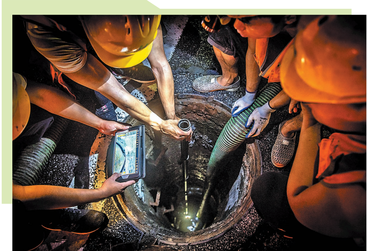
我市已经完成约119公里的排水管网清淤,修复约1874米。
