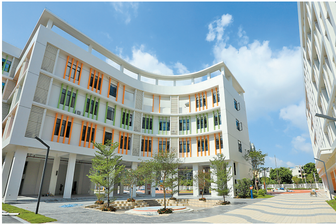
新建成的珠海潮联学校已投入使用。
