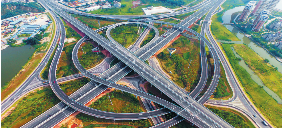
俯瞰金湾立交全景。
