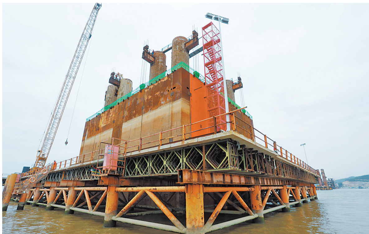
金海大桥29号墩钢围堰沉放安装现场。 本报记者 钟凡 摄
