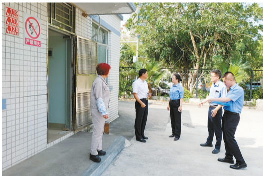
2018年3月30日,人大代表(左二)在南屏停止工作的泵房前向检察人员反映污水直排现象。
