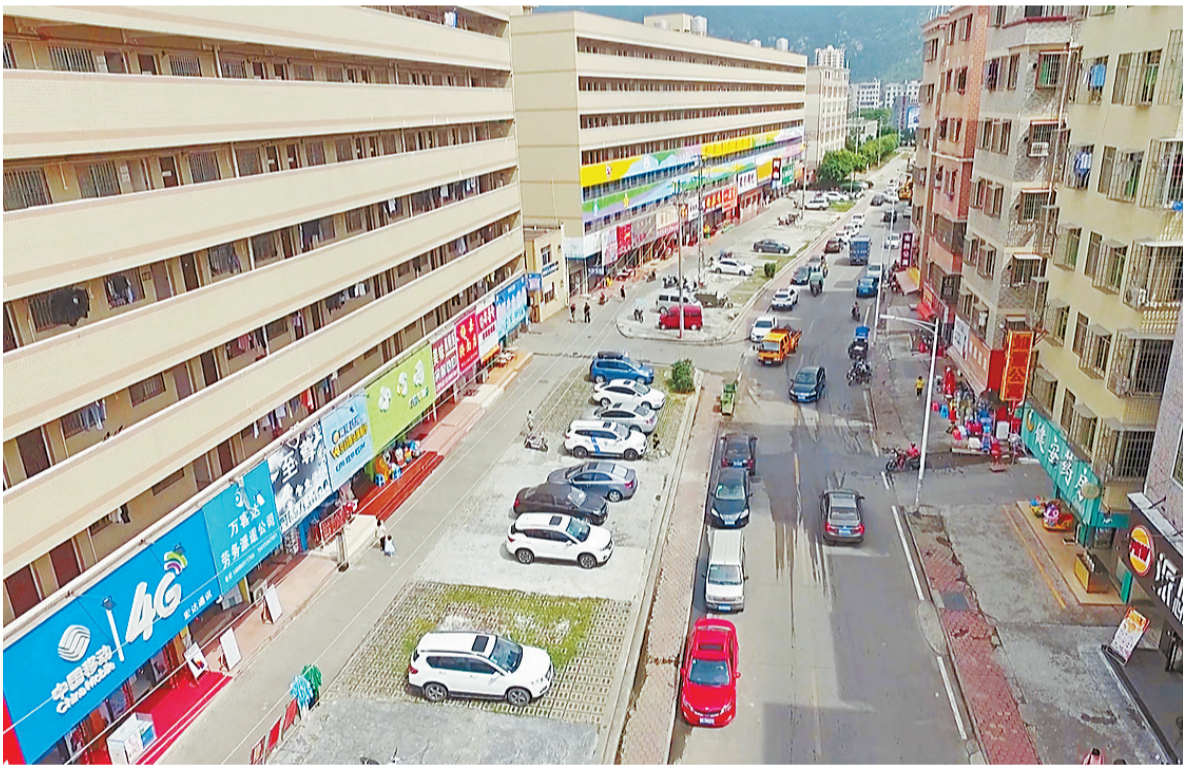
斗门区珠峰大道西埔市场段的违章建筑已清拆完毕。
