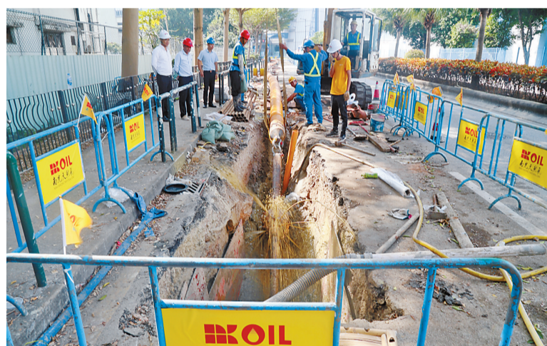
11月27日,工作人员在进行拖管施工。 本报记者 陈新年 摄
