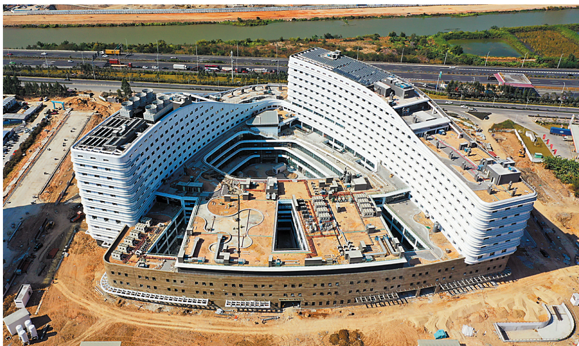
珠海市妇幼保健院洪湾院区主楼基本完工,正在进行室内外装修。 本报记者 赵梓 摄
