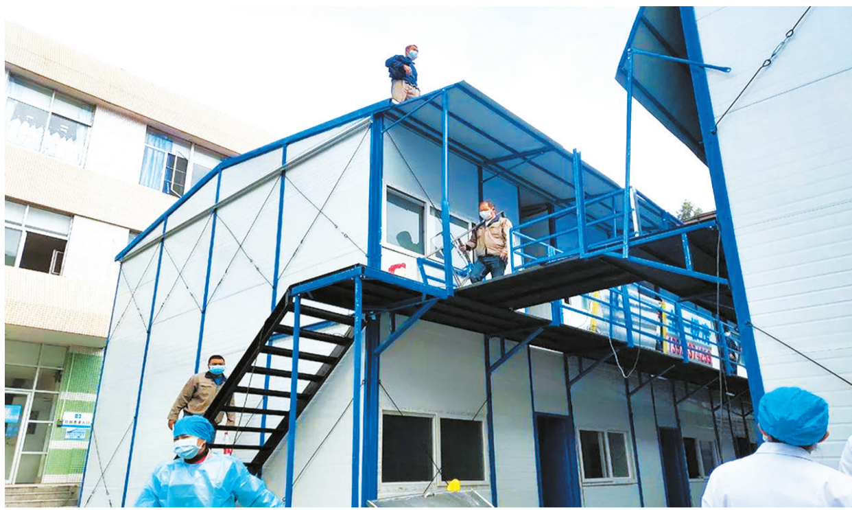
珠海市人民医院医疗应急工程。 华发集团供图
