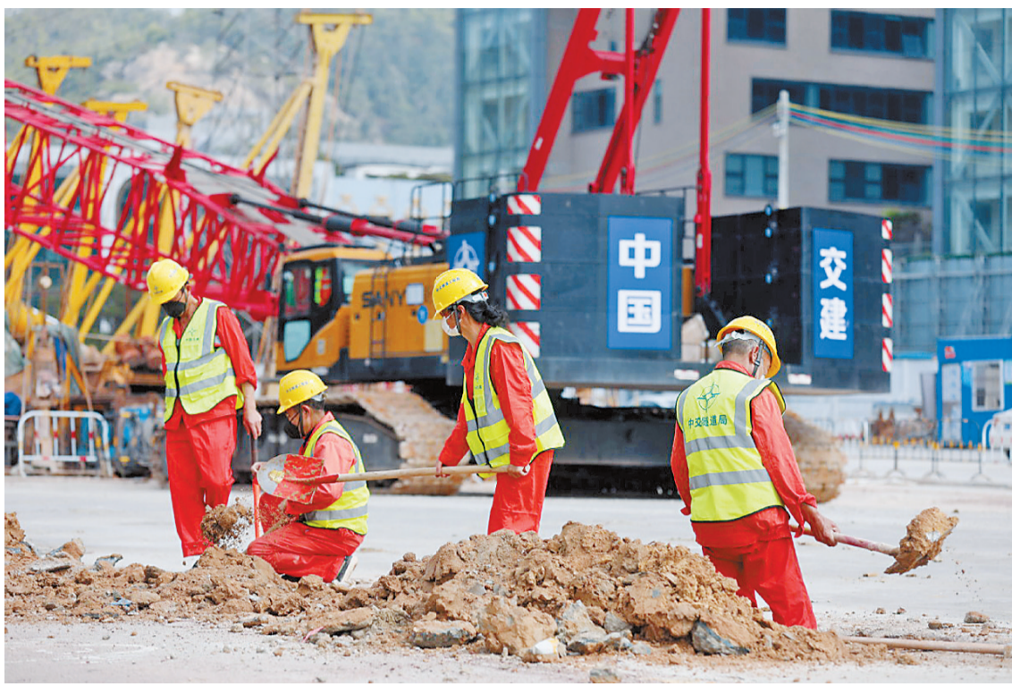
2月24日,兴业快线(南段)二标段施工现场施工人员正挥锹铲土。
