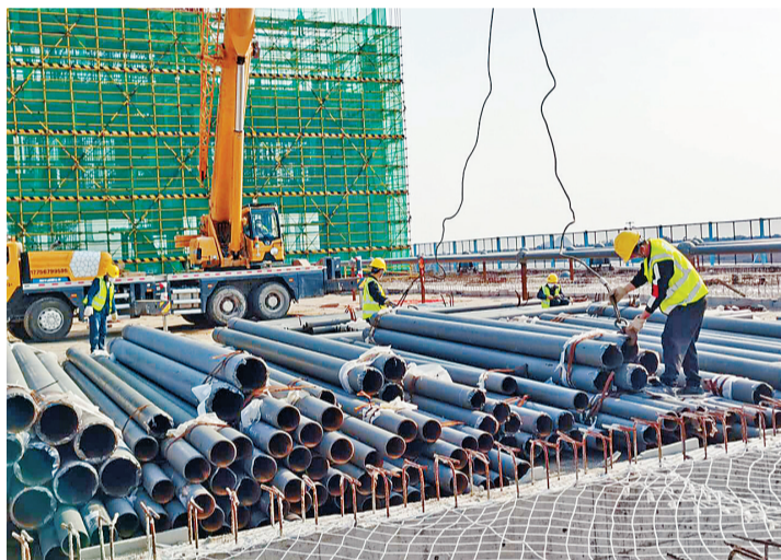
施工人员在珠海航展中心配套服务设施提升工程(一期)项目现场有序开展施工。
