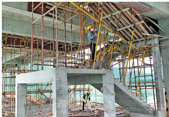
施工人员在珠海航展中心配套服务设施提升工程(一期)项目现场有序开展生产工作。
