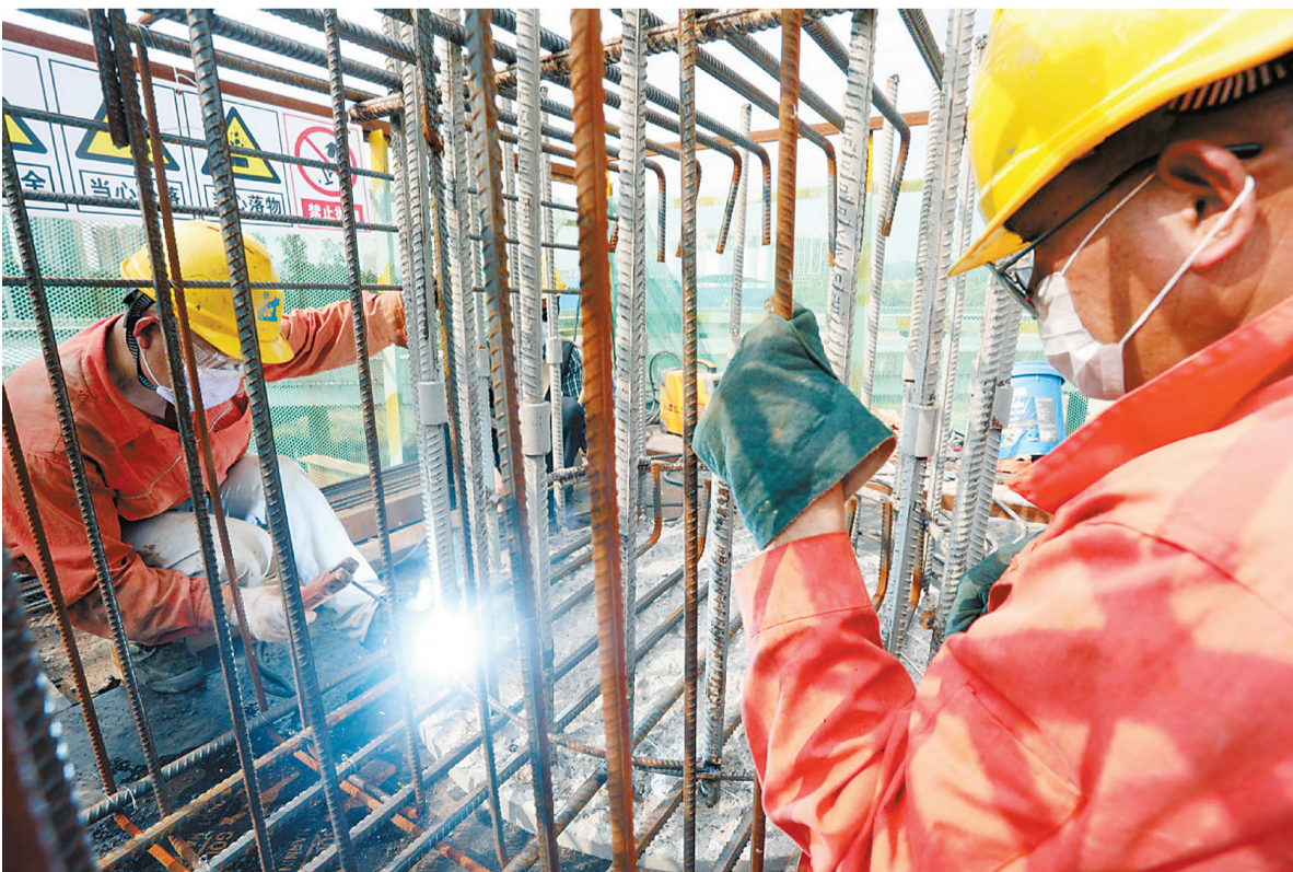
2月26日,香海大桥坦洲互通的F匝道施工现场,工人正加紧施工。 本报记者 钟凡 摄
