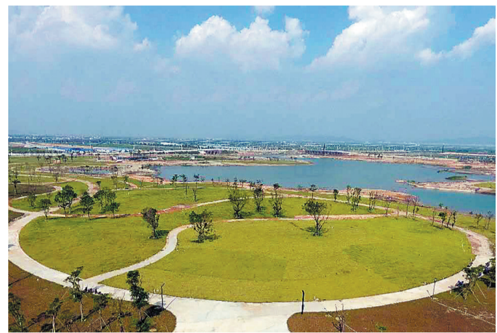
建设中的平沙新城。本报记者 张洲 摄
