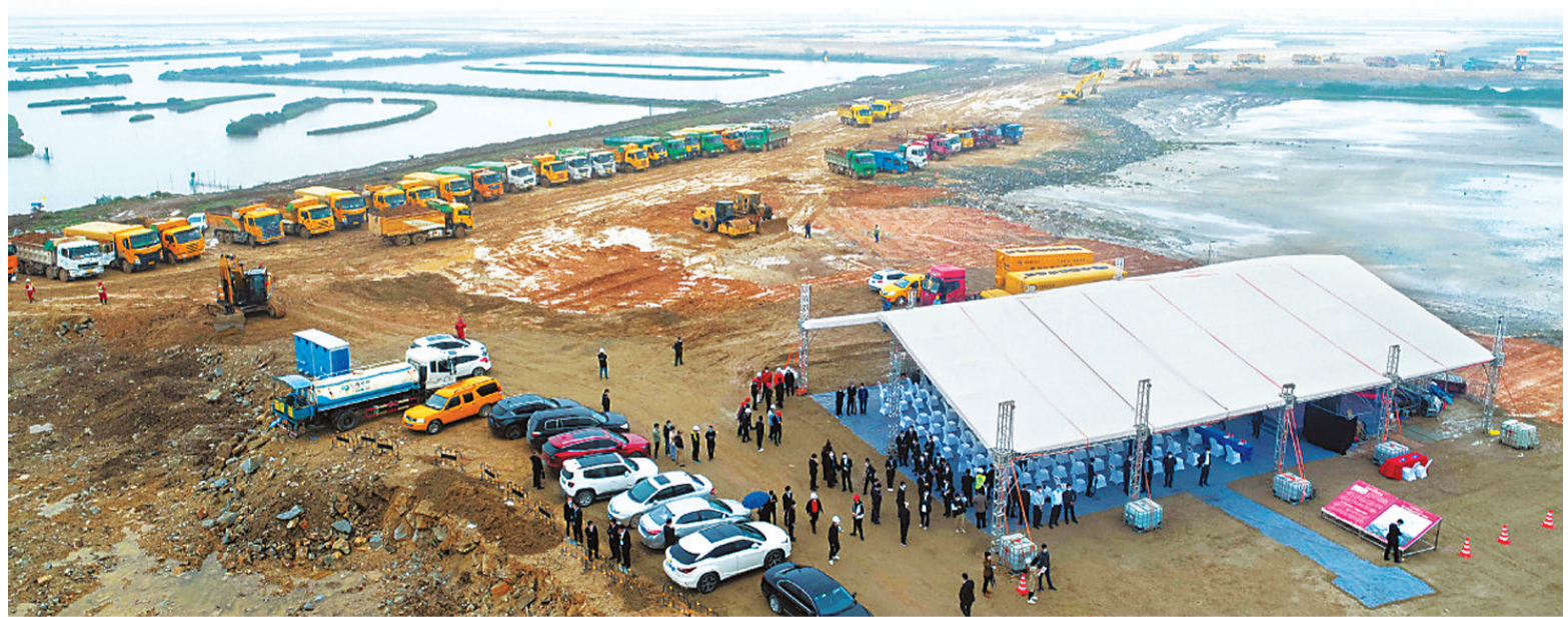
格力电器高栏产业园项目现场。本报记者 张洲 摄
