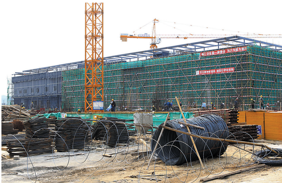
建设方通过增加人员、备足物料等方式,抢回失去的工期。 本报记者 张洲 摄
