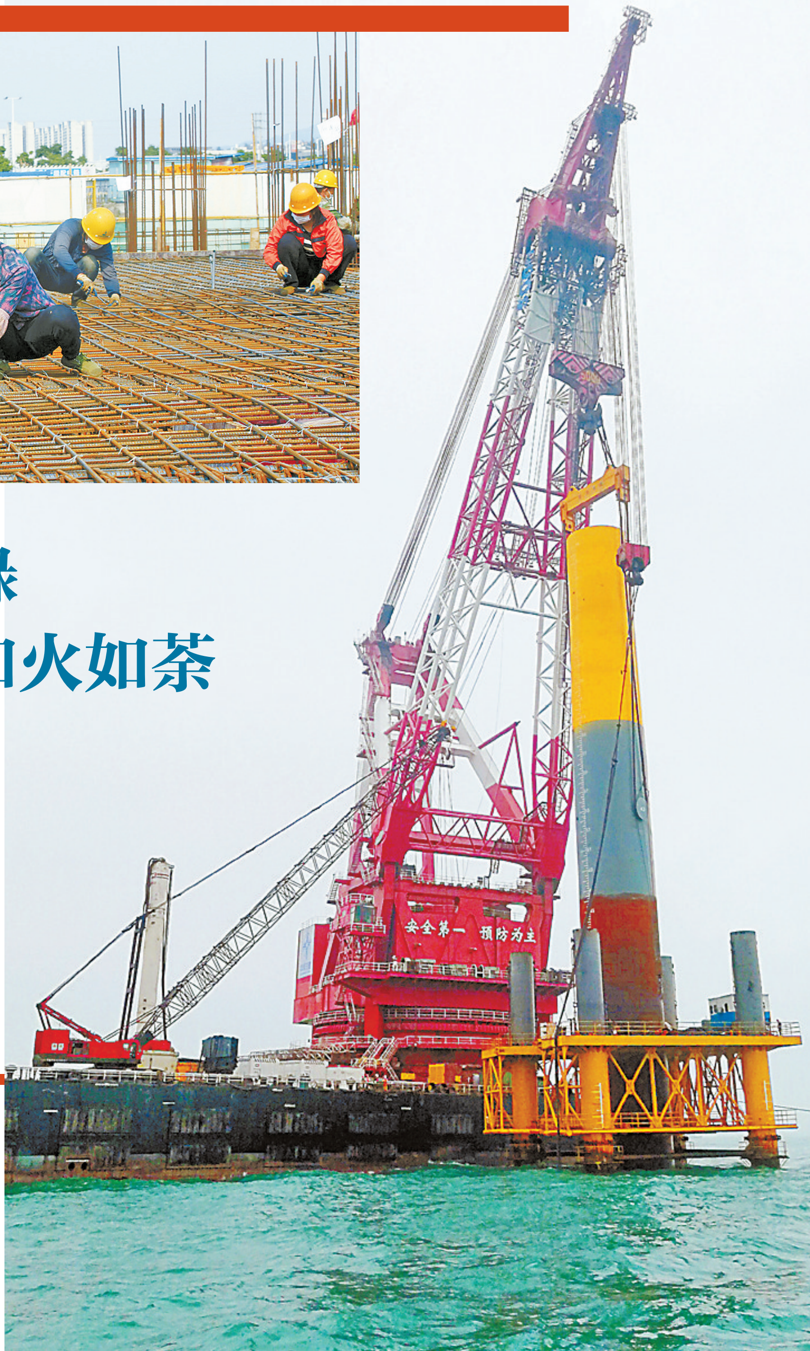
4月6日,珠海金湾海上风电场项目施工现场,施工人员进行一根根钢管桩插入海底。
