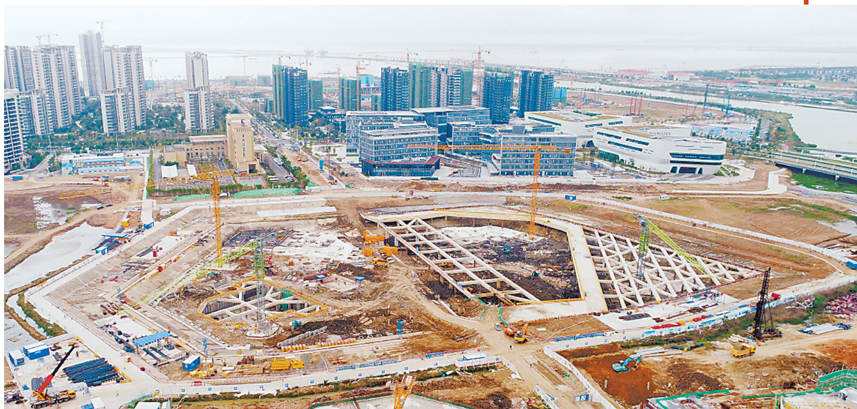
4月9日,金湾航空城市市民艺术中心建设现场。
