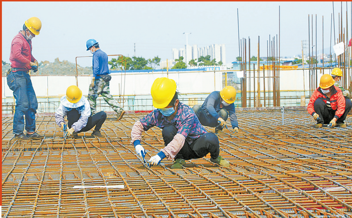
珠海动力港施工现场,工人们正在绑扎钢筋。
