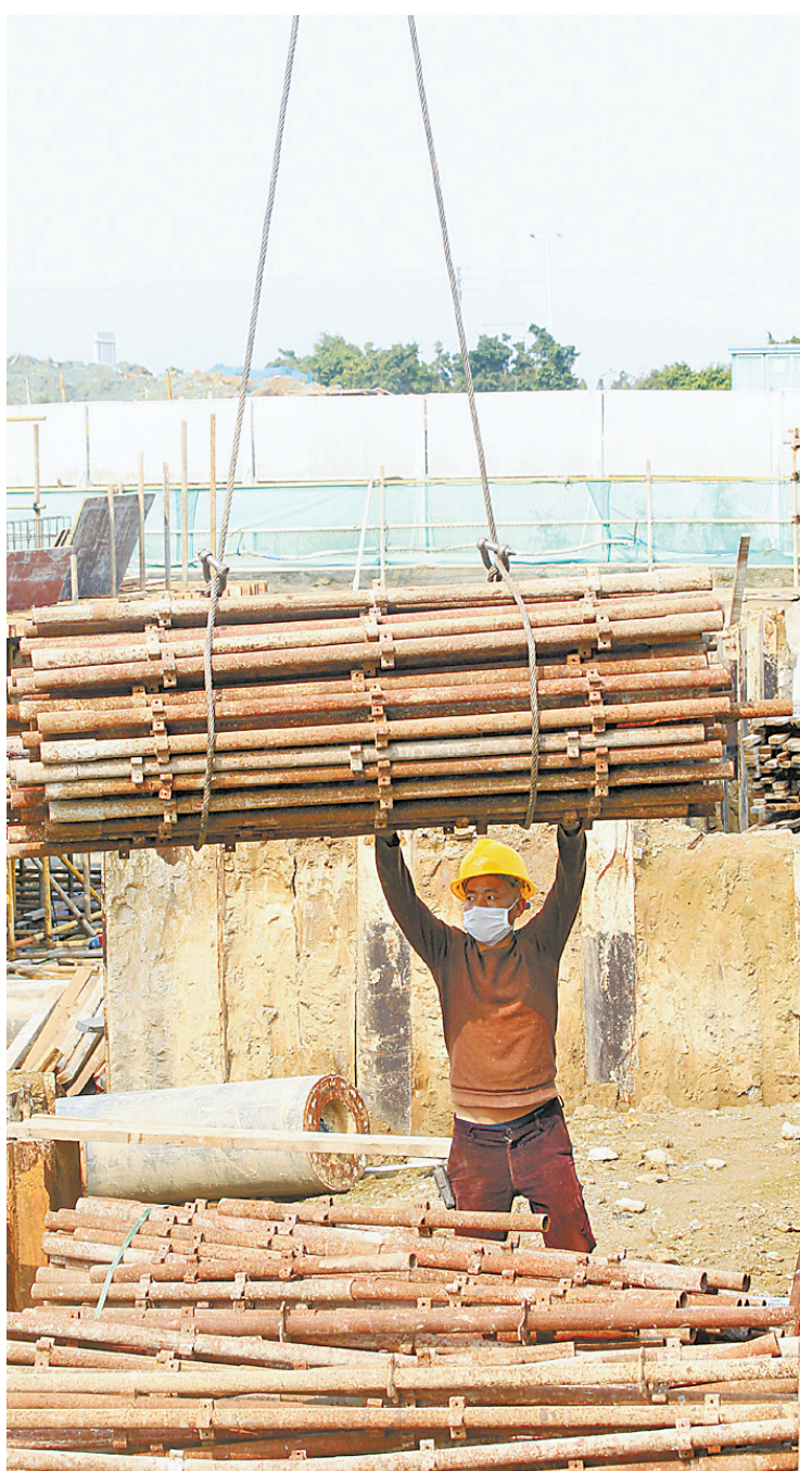
珠海动力港施工现场,一名工人在协助机械运输钢材。
