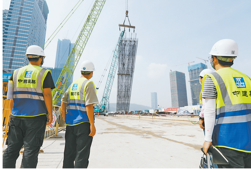
十字门隧道工程施工现场。 本报记者 李建束 摄
