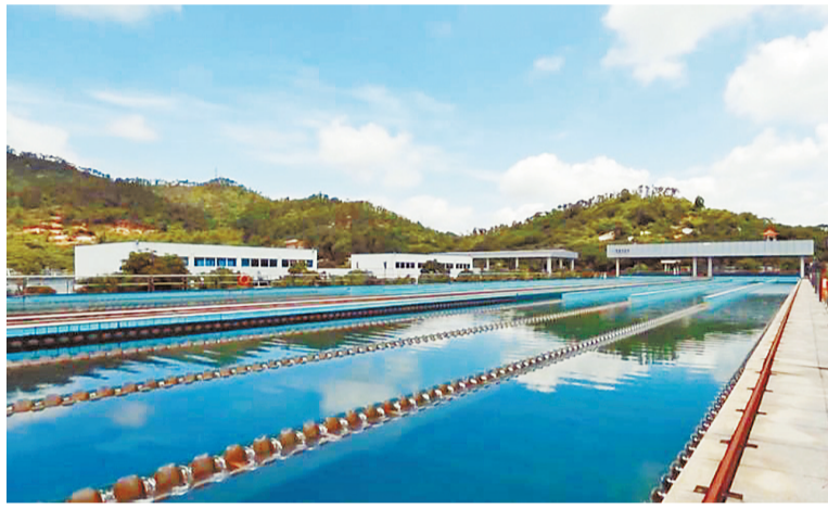
乾务水厂的沉淀池。 本报记者 吴长赋 摄
