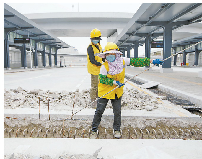
横琴口岸的工人正在施工确保工期顺利完成。
