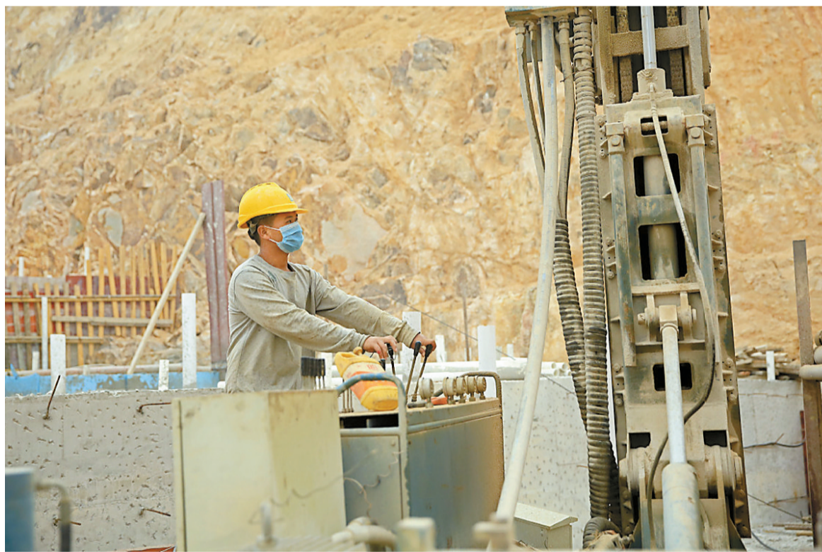
22日,工作人员在流水坑水库工地加紧施工。本报记者 程霖 摄
