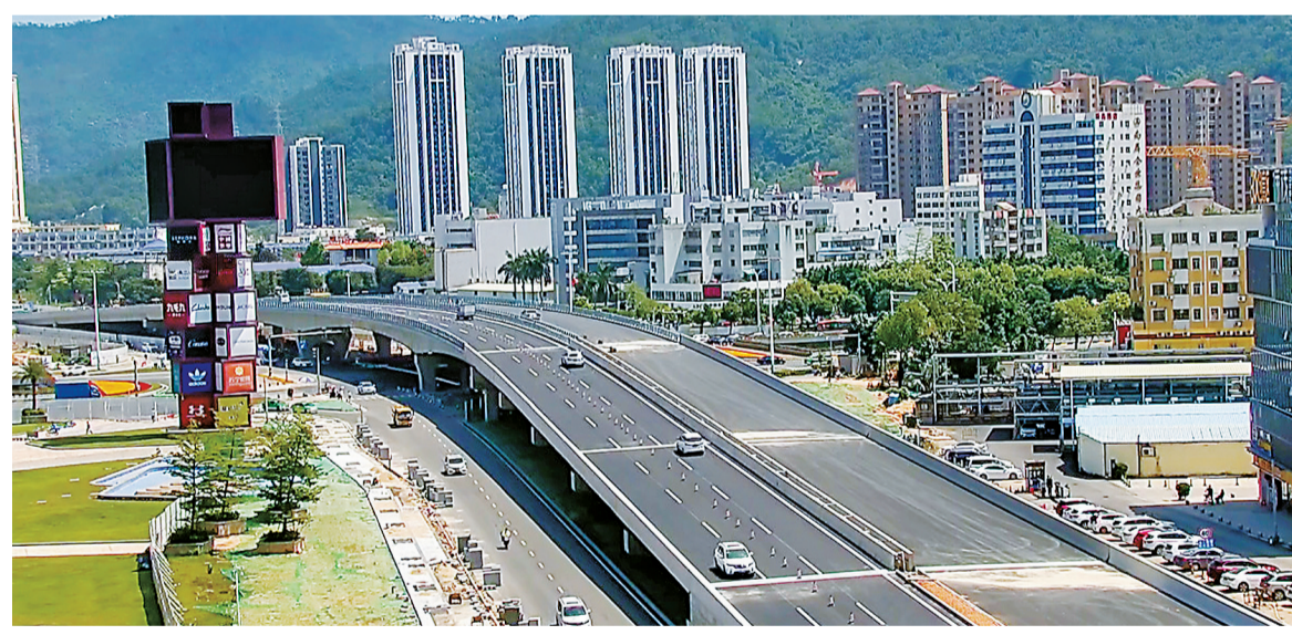
4月29日,金琴快线珠海大道跨线桥东侧桥梁临时开放双向通行。
