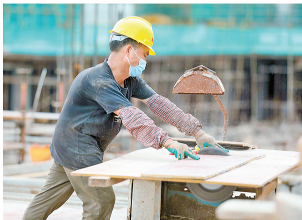
建粤商务中心正在施工建设中。
