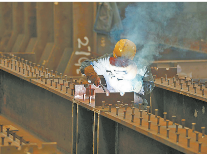
东方重工工作人员对桥梁钢结构进行作业。
