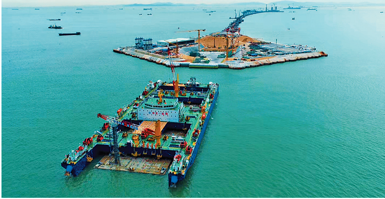
E2管节在靠近中山方向的深中通道西人工岛附近沉放安装。 通讯员 卢志华 摄
