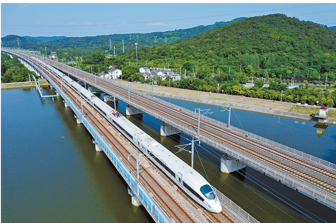
一列和谐号动车组列车驶经京沪高速铁路南京段。
