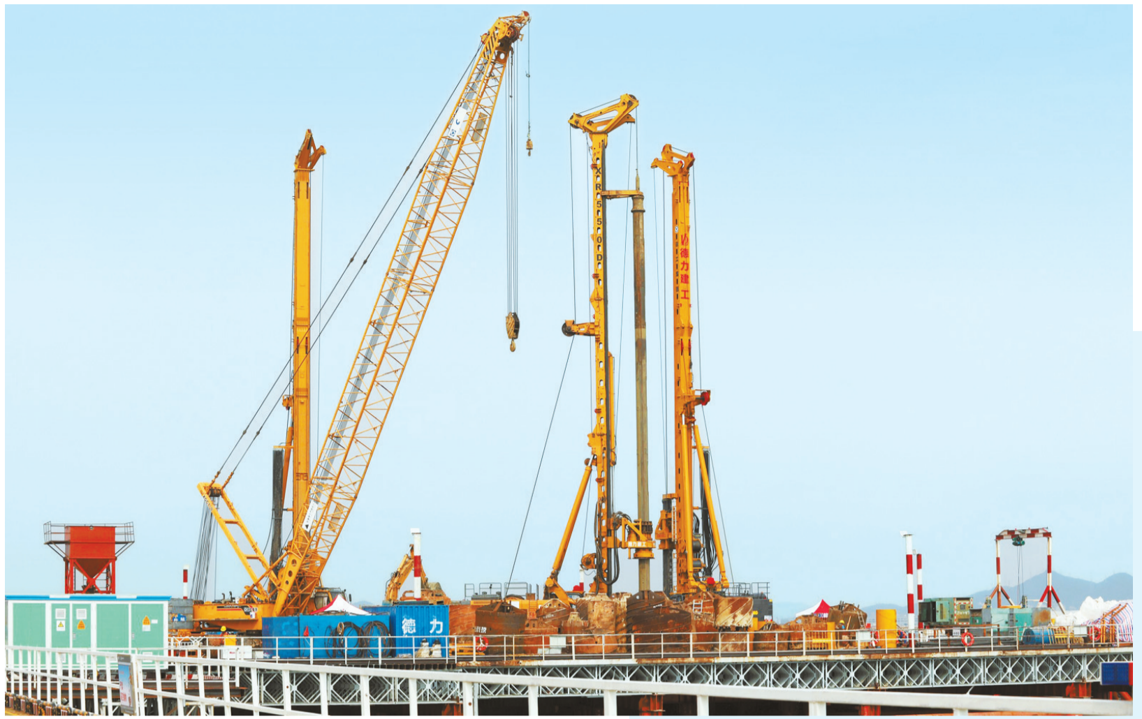
黄茅海跨海通道高栏港大桥Z4#墩墩作业平台上3台先进的旋挖钻齐声轰鸣。
